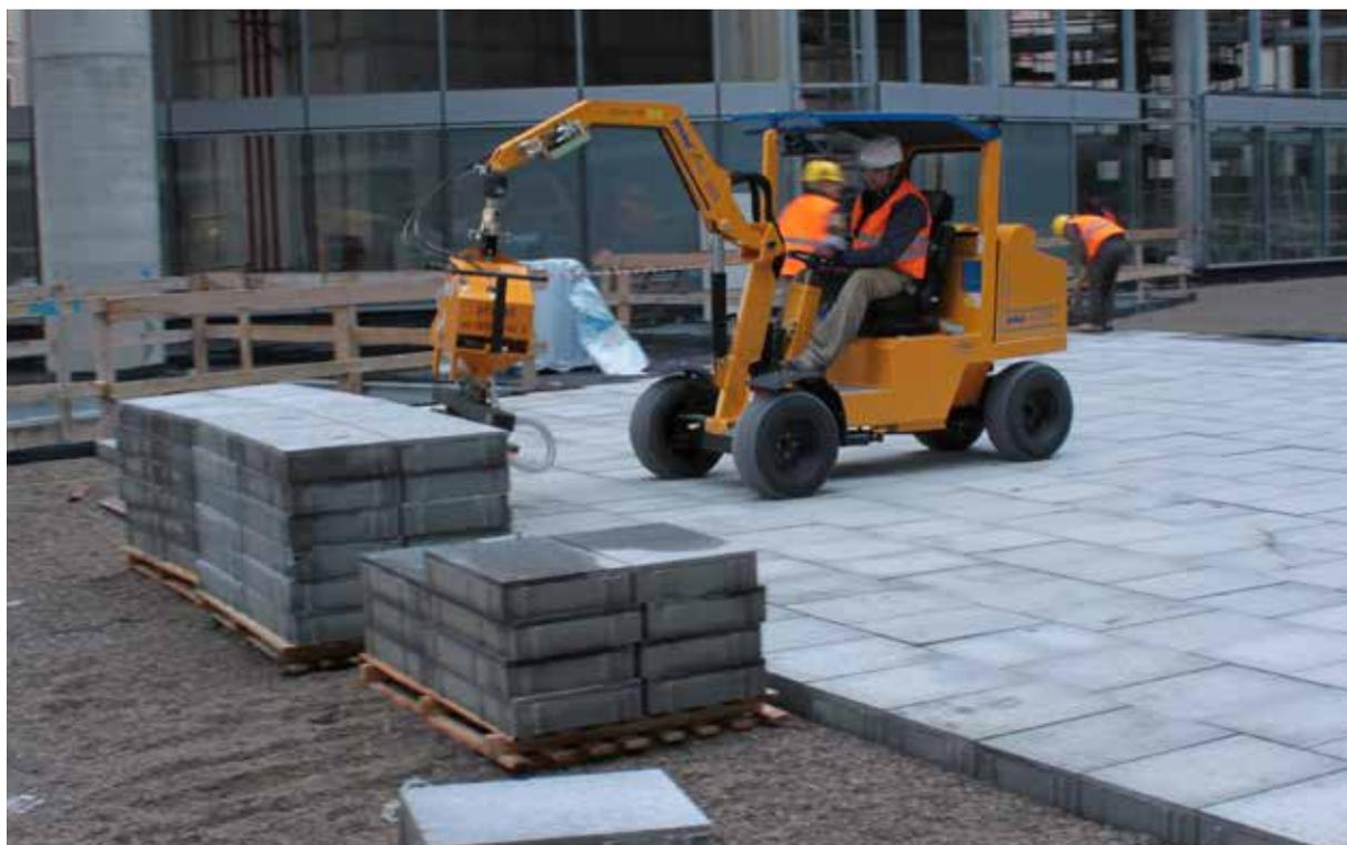
**P**avimentazione in lastre composite di calcestruzzo e pietra naturale aventi dimensioni 60x40 cm e spessore 11 cm, costituite da un supporto base di spessore 9 cm connesso saldamente allo strato di finitura superficiale di 2 cm.
